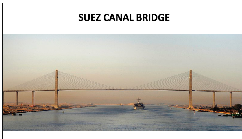
Fig. 3 – Ponte sul Canale di Suez
